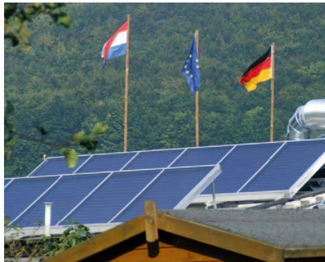
Slika 1: Sanitarije kampa Auenland v Hessnu z LBM kolektorji
