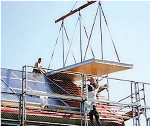
Slika 4: Racionalna montaža z dvigalom
